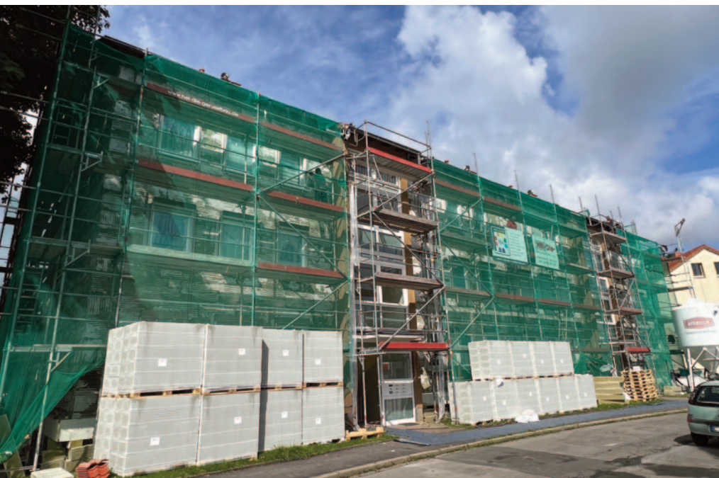
Energetische Sanierung Lerchenstraße 11/13 (12 WE)
