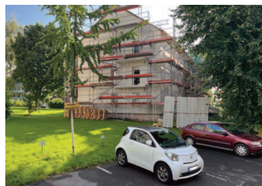
Energetische Sanierung Hermannstraße 1c/1d (12 WE)
