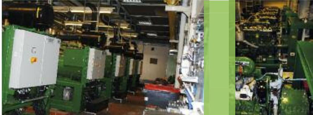
Generator wandelt die Energie aus dem Motor in elektrischen Strom um, ein Wärmetauscher macht die anfallende Abwärme als Heizenergie brauch-bar. Das hat den großen Vorteil, dass beim Trans-port der Fernwärme nur wenig Verlust entsteht. Auch das Nahversorgungszentrum Neue Bomme-raner Mitte mit Supermärkten, die Helene-Loh-mann-Realschule und das Sportzentrum des TuS Bommern nutzen Bioenergie.
